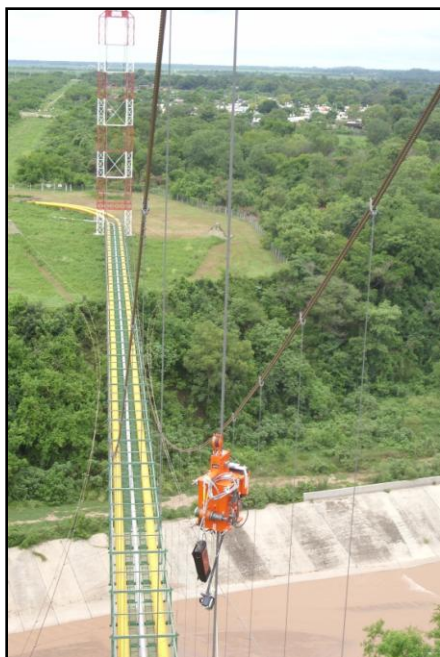
Fig. 5 – Inspección de un cable vertical utilizando el Climber
